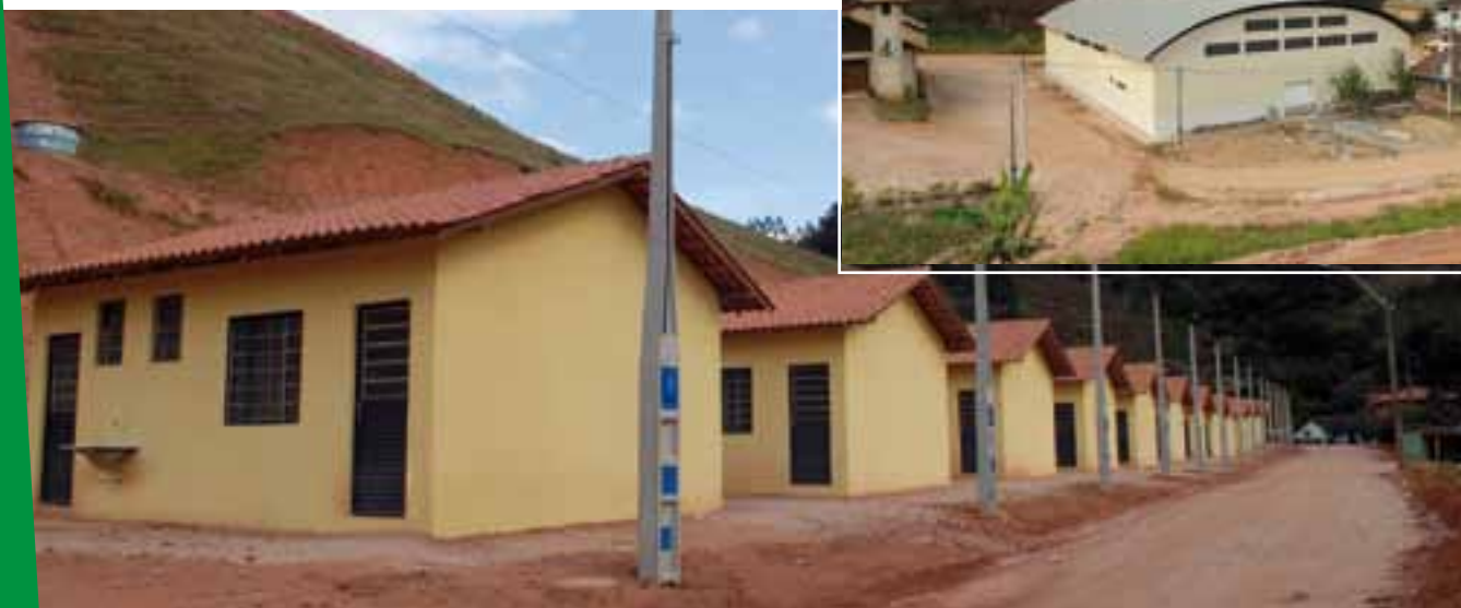
Construção de casas populares na Comunidade Camargo
