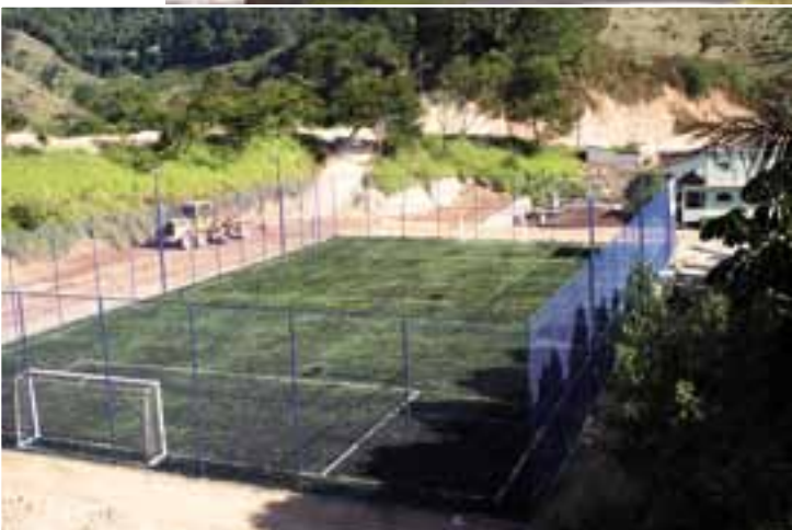
Construção do campo society no Bairro Bananeiras
