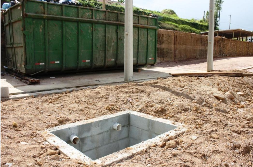
Foto 04 – Caixa impermeabilizada para coleta do chorume, com ligação às canaletas.
