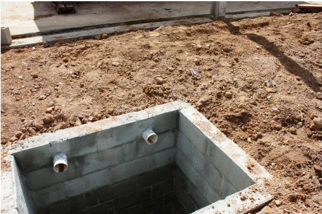
Foto 05 – Detalhes da caixa coletora de chorume.
